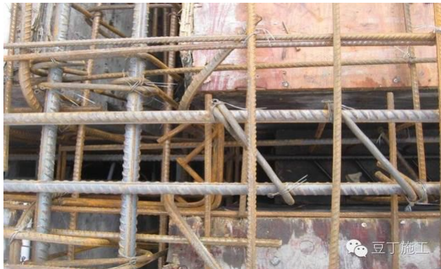
3) 框架梁柱节点核心部位柱箍筋堆匝
